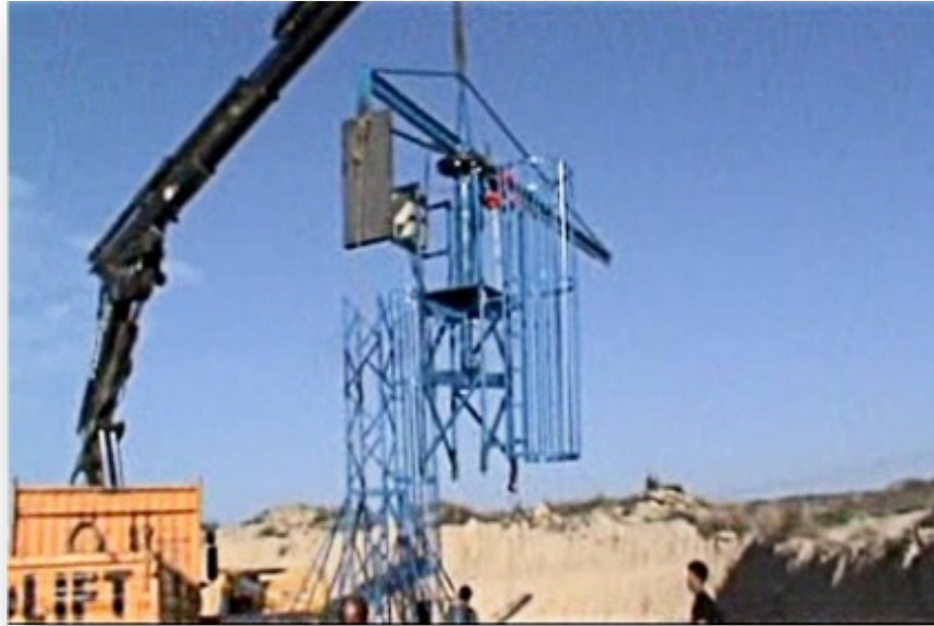
Figura 04: Grúa torre desmontable en proceso de montaje
