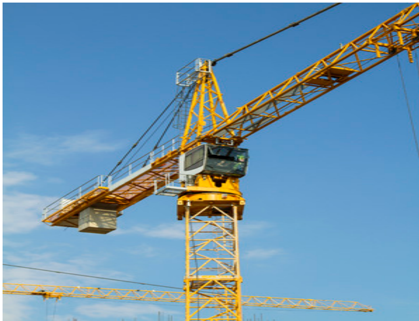
Figura 01: Grúa torre en funcionamiento.
