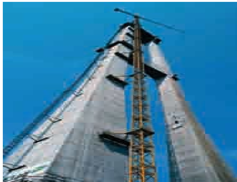
Figura 07: Grúa torre trepadora instalada en un edificio
